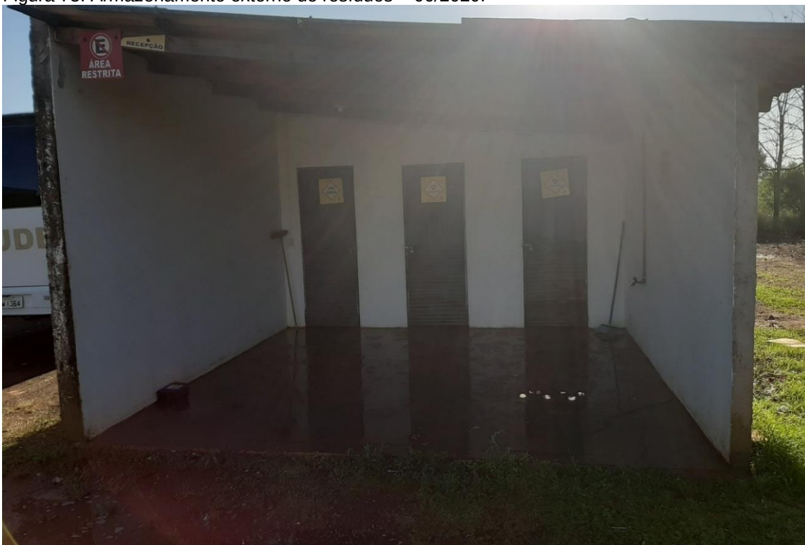
Figura 73: Armazenamento externo de resíduos – 06/2020.
