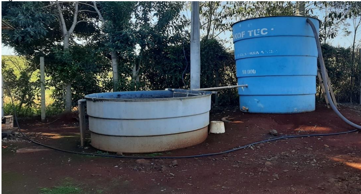
Figura 51: Tanque de entrada – visita 06/2021.
