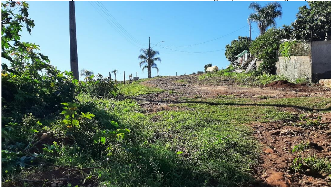
Figura 114: Via não pavimentada sem sistema de microdrenagem (Rua Vitório Pagliosa).
