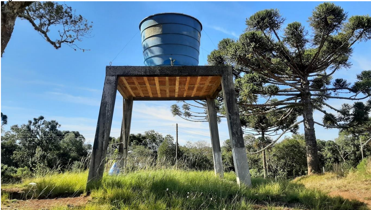
Figura 45: Reservatório em PRFV elevado - 5 m 3 – 06/2021.
