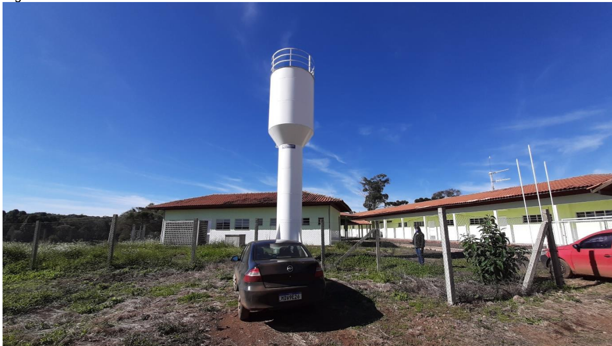
Figura 47: Reservatório Metálico - 30 m 3 - 06/2021.
