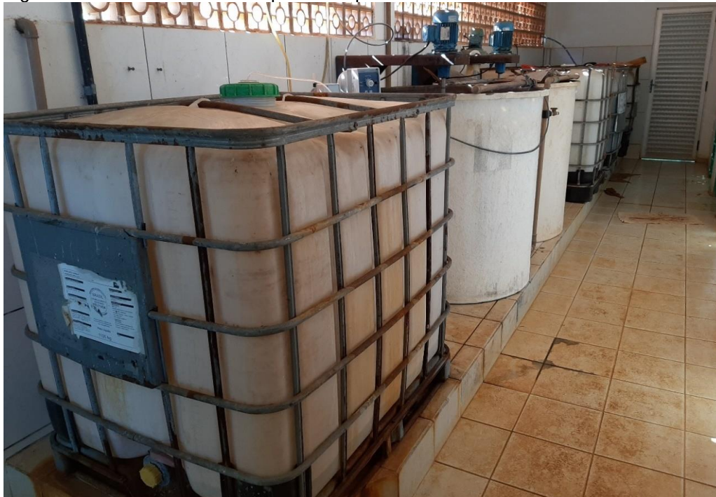
Figura 29: Armazenamento dos produtos químicos - 06/2020.
