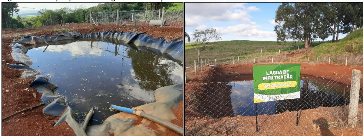
Figura 70: Tanque pulmão + lagoa de infiltração - 06/2020.
