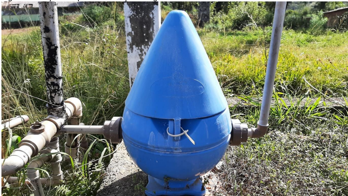
Figura 42: Dispositivo para desinfecção da água através de tabletes de cloro – 06/2021.
