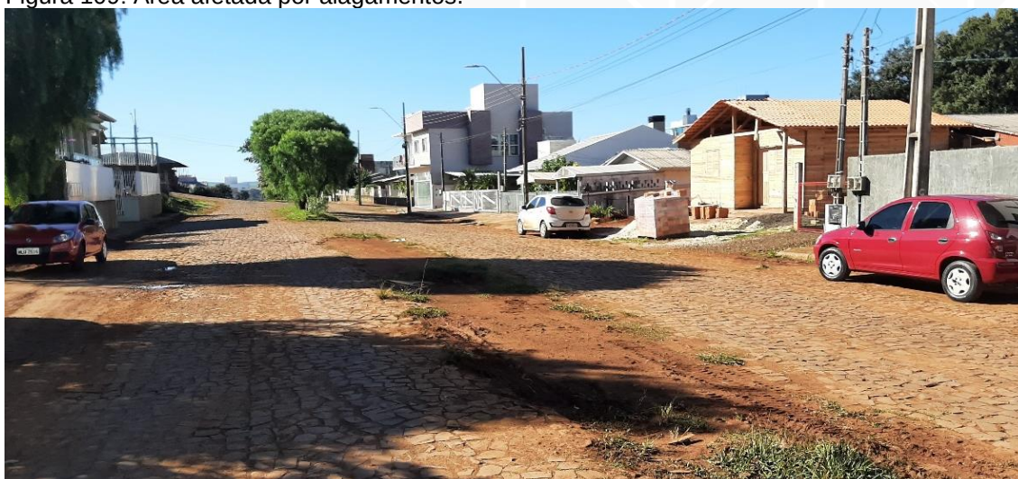
Figura 109: Área afetada por alagamentos.
