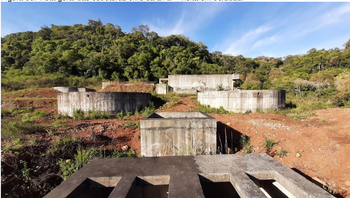
Figura 56: Vista geral das estruturas civis da ETE – visita em 06/2021.
