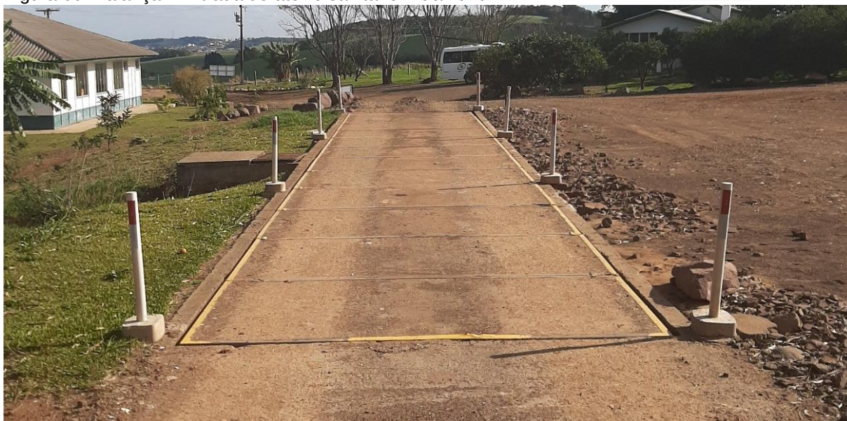
Figura 60: Balança - Entrada do aterro sanitário – 06/2020.
