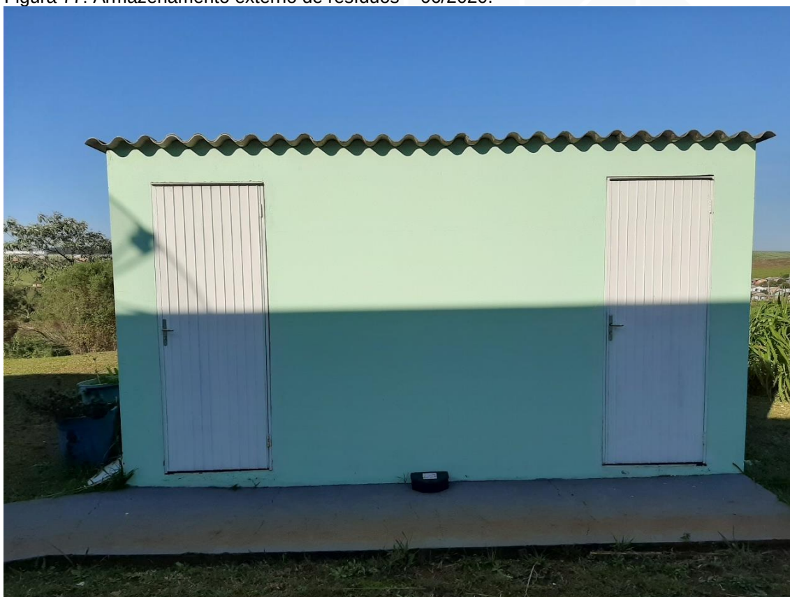
Figura 77: Armazenamento externo de resíduos – 06/2020.
