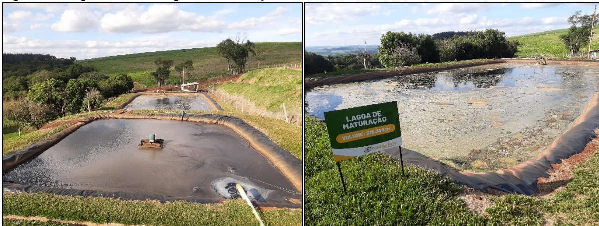
Figura 69: Lagoa aerada + lagoa de maturação - 06/2020.
