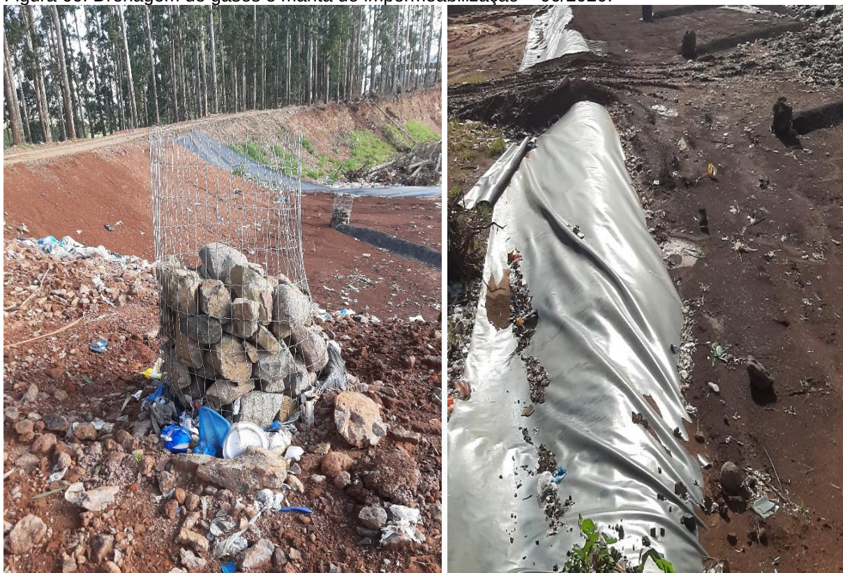
Figura 66: Drenagem de gases e manta de impermeabilização – 06/2020.
