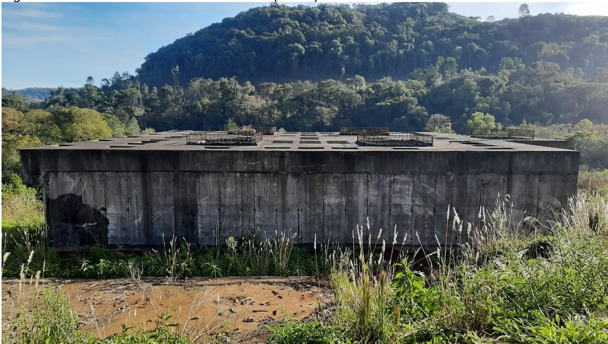
Figura 55: Estrutura civil do reator anaeróbio (UASB) – visita em 06/2021.
