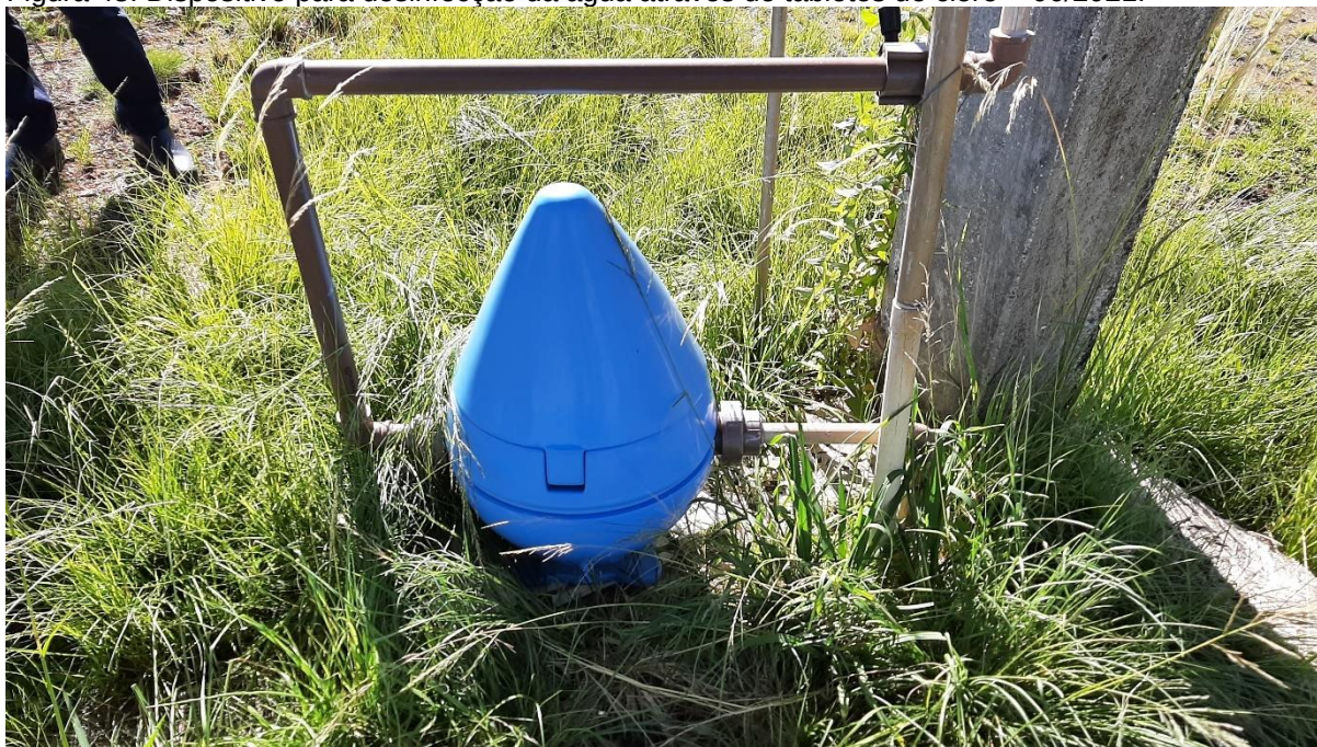
Figura 48: Dispositivo para desinfecção da água através de tabletes de cloro – 06/2021.
