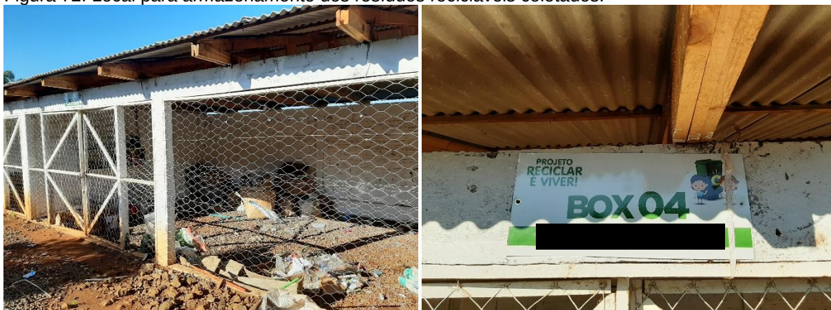
Figura 72: Local para armazenamento dos resíduos recicláveis coletados.
