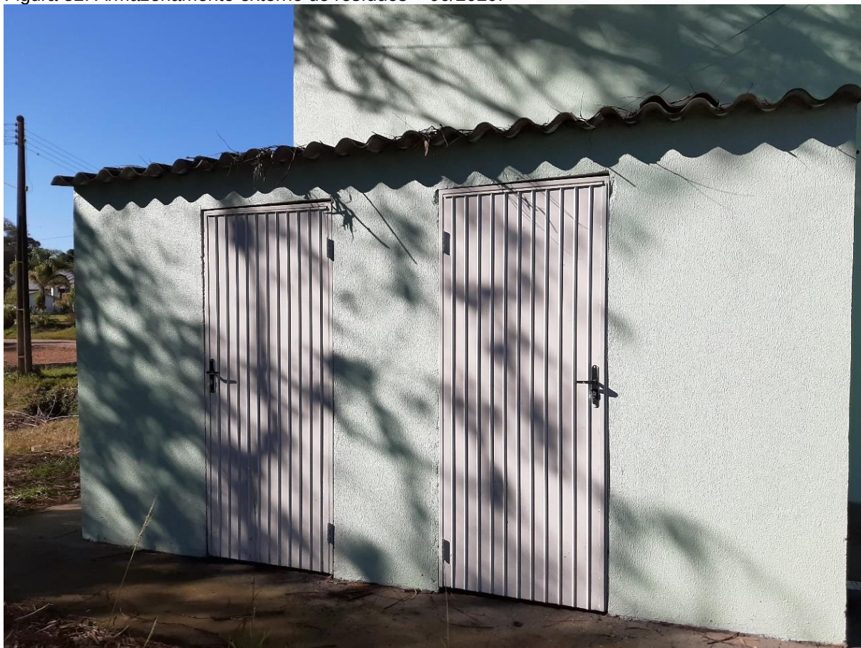
Figura 82: Armazenamento externo de resíduos – 06/2020.
