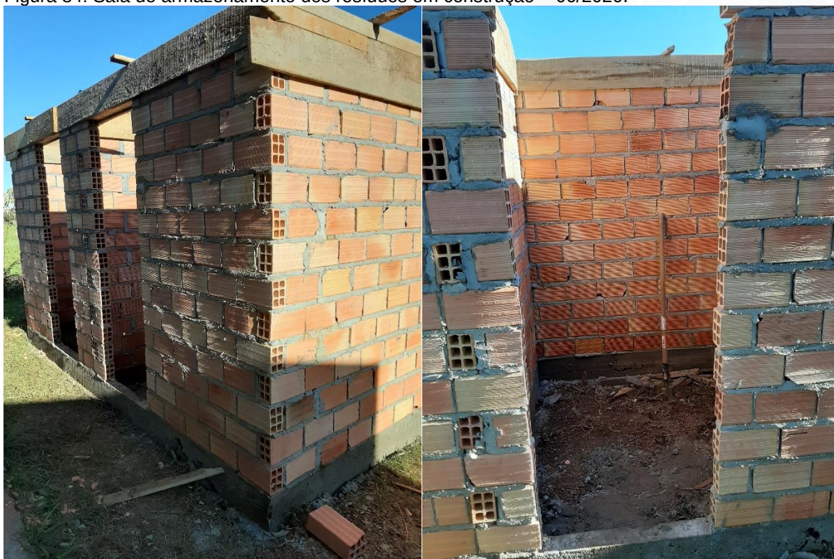
Figura 84: Sala de armazenamento dos resíduos em construção – 06/2020.
