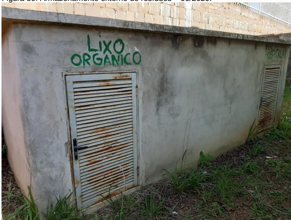
Figura 80: Armazenamento externo de resíduos – 06/2020.
