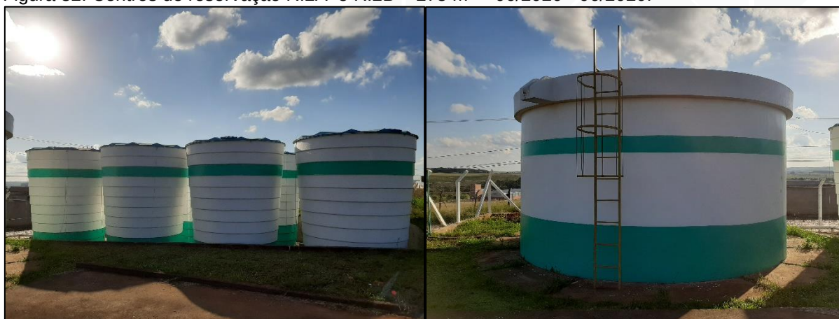
Figura 32: Centros de reservação R.2A e R.2B – 275 m 3 – 06/2020 - 06/2020.
