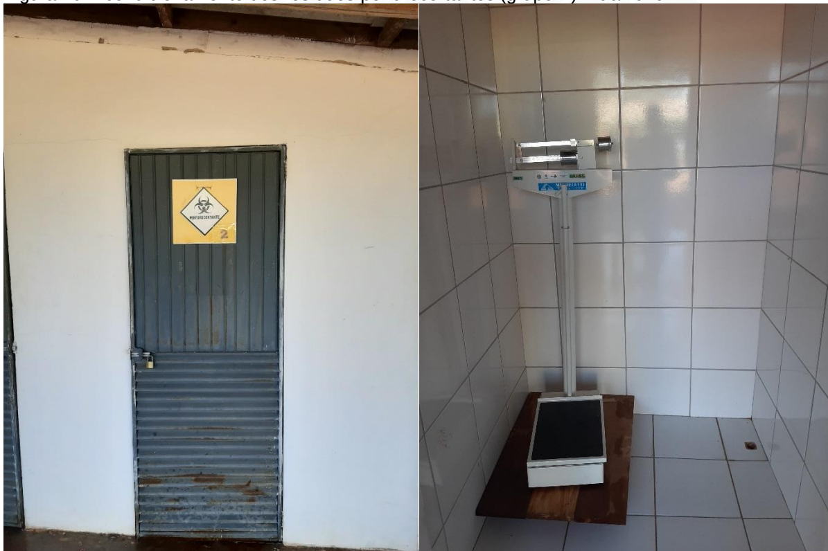
Figura 76: Acondicionamento dos resíduos perfurocortantes (grupo E) – 06/2020.
