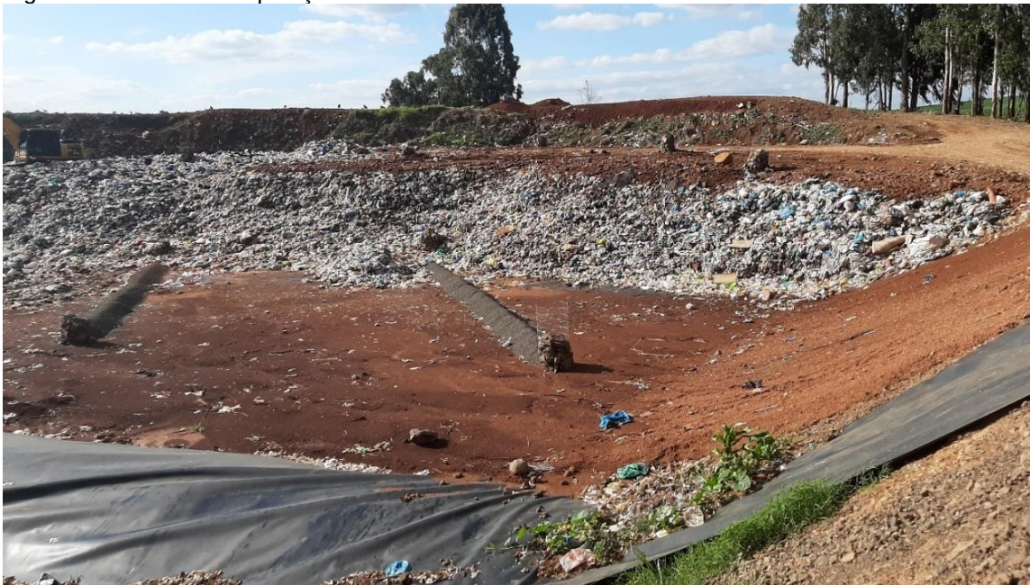
Figura 64: Célula de disposição dos resíduos - 06/2020.
