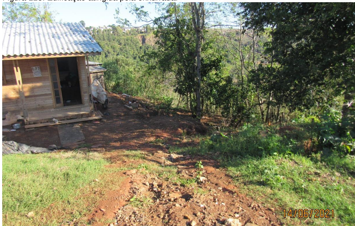
Figura 113: Edificação atingida pela enxurrada.
