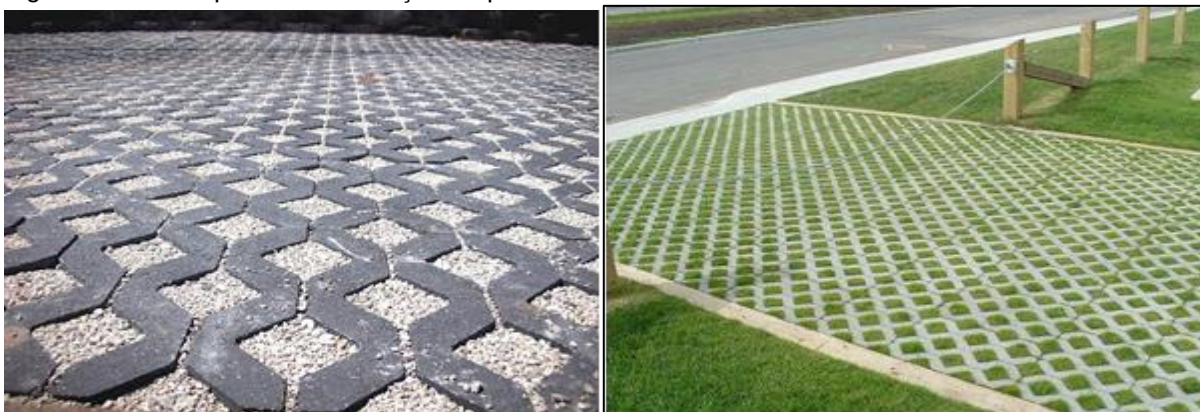
Figura 115: Exemplos de valorização da permeabilidade dos solos.
